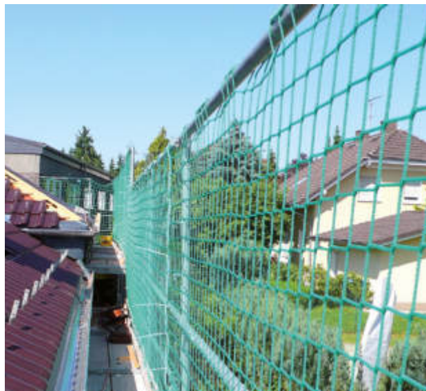
Das Gerüstrohr ist Masche für Masche durch das Netz gezogen.
